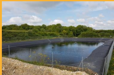
Bassins de lixiviats de 5 000 m 3
