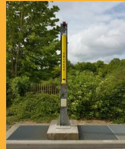
Portique de détection de radioactivité
