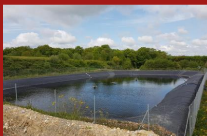
Bassins de lixiviats de 5 000 m 3
