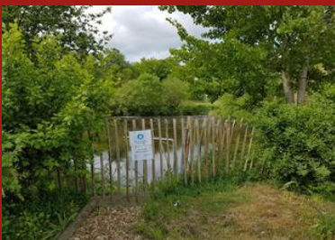
Bassin des eaux de ruissellement
